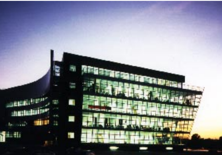
Das Düsseldorfer Kai-Center gehört zu den Vorzeigeprojekten des Architekturbüros ddj
